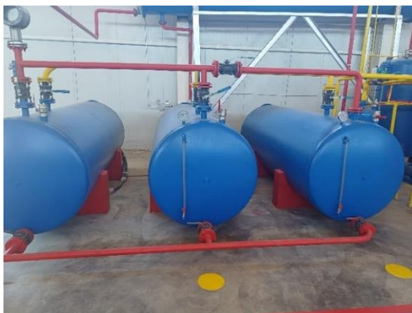
Slika 23. Rezervoari za različite frakcije goriva u sklopu uljnog postrojenja
