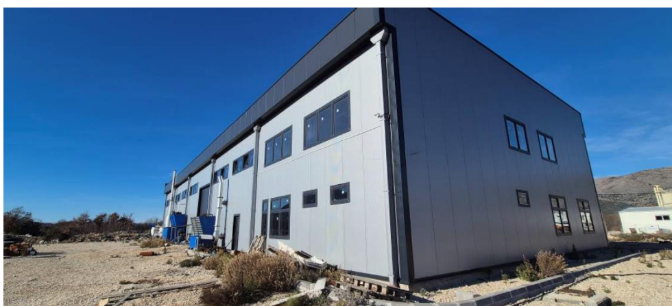
Slika 32. Pogled na postojeći objekat iz pravca jugoistoka
