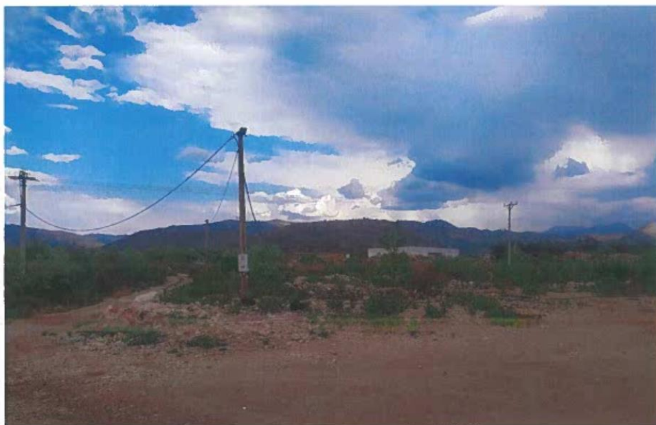
Slika 1. Prikaz lokacije predmetne MBTS "6-D", naponskog nivoa 10 (20)/0.4 kV
