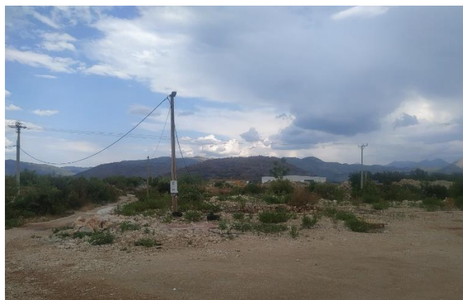
Slika 41. Prikaz lokacije predmetne MBTS "6-D", naponskog nivoa 10 (20)/0.4 kV
