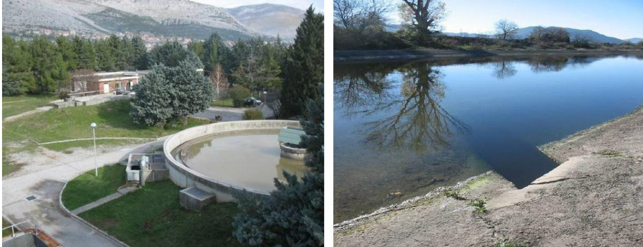
Слика 31: Уређај за пречишћавање отпадних вода и испуст у ријеку Требишњицу
